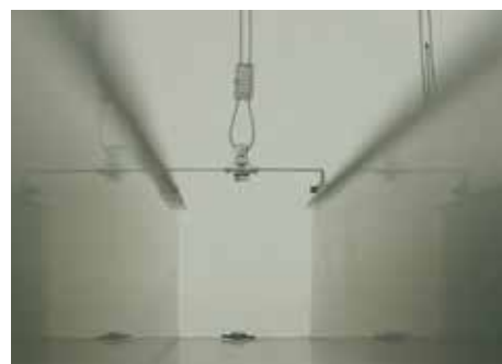
Obrázek zobrazující adaptér a lanové zavěšení na místě, které nabízí mechanické upevnění k bezpečným a rovným rozvodům.
